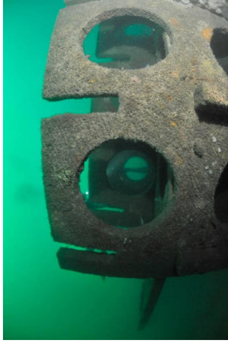
Illustration de l'affaissement général de la structure et la chute des plaques horizontales. Hauteur maximum atteinte de 3.5m contre 6m à l'immersion.
