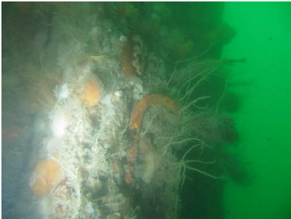
Figure 19 : Illustration de la mise à nu de fers à béton lors de la chute de plaques.
