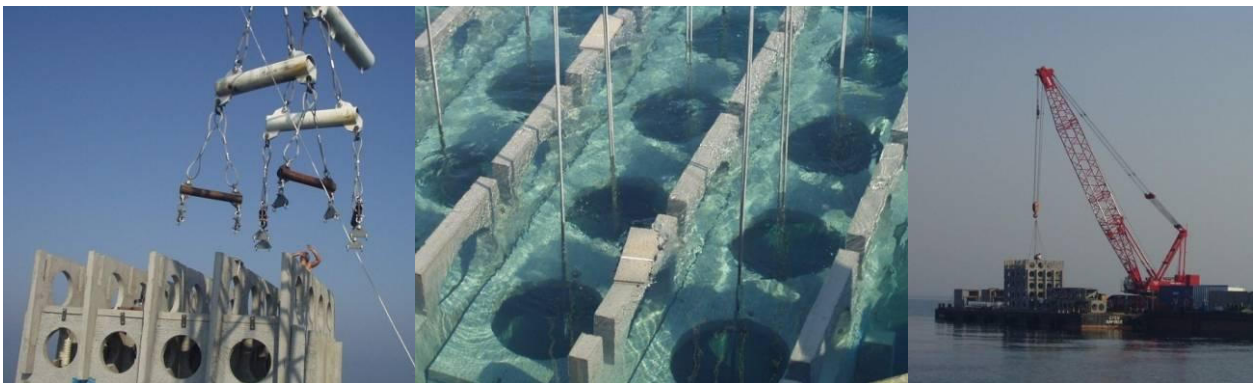
Figure 7 : Illustration du gros module (6 mètres de hauteur) lors de la pose en 2003.
