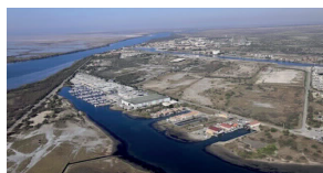
Vue aérienne de Port-Saint-Louis-du-Rhône (ville de Port-Saint-Louis-du-Rhône)
